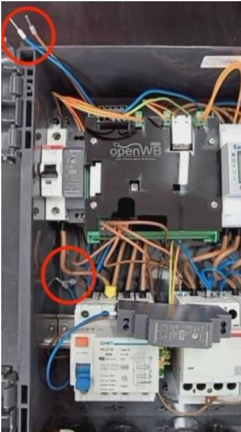
Einbau zusätzliches 5 V DC Hutschienennetzteil auf unterer Tragschiene
